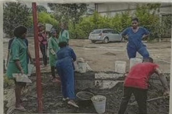
So wurde angepackt: Beseitigung von Schäden nach der Flut im Mai.
