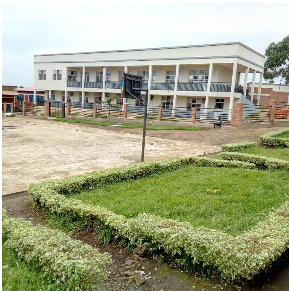
Das Gebäude für das AI Niveau ist fertig
